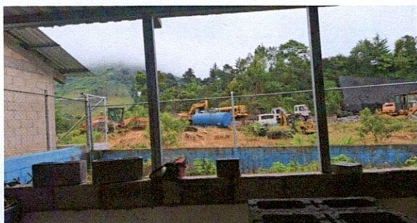
Foto 1: Inicio de Mampostería de Block de la Cocina
