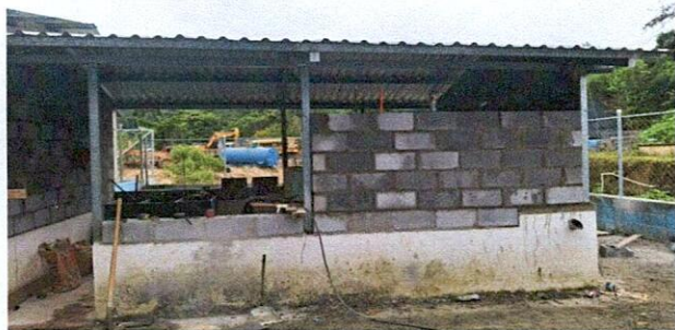
Foto 5: Se limpian y humedecen las superficies, se aplica la mezcla de mortero, se nivela y alisa la pared, y finalmente se deja fraguar para obtener un acabado uniforme y resistente.
