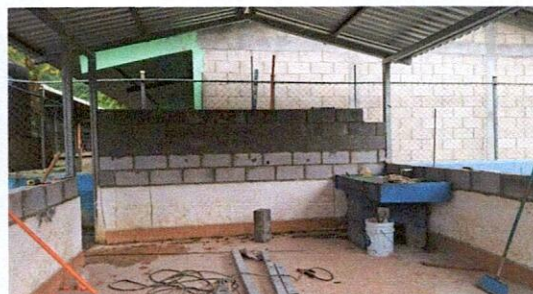
Foto 2: Avance en la construcción del muro de block, con colocación alineada y nivelada, asegurando estabilidad y buen acabado.
