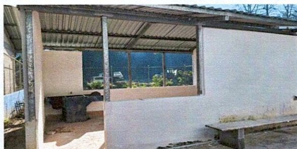
Foto 6: Relleno de paredes realizado, garantizando uniformidad y buen acabado.
