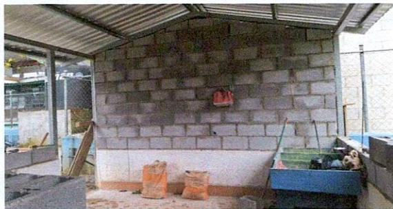
Foto 3: : Muro de block finalizado con correcta alineación, nivelación y acabado conforme a las especificaciones del proyecto.
