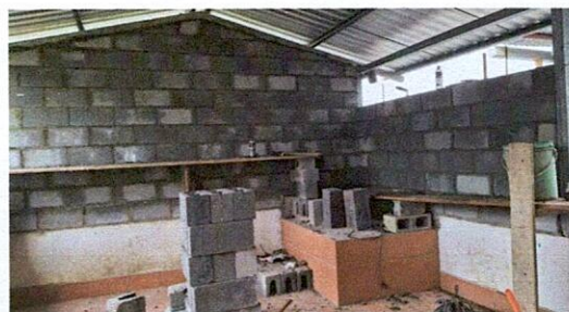
Foto 4: Foto 6: El levantamiento del muro de la cocina ya va a un 50%
